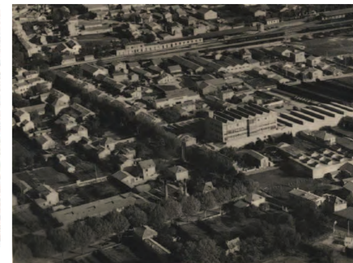
Quartier industriel entrée Ouest depuis Avignon, vue aérienne
