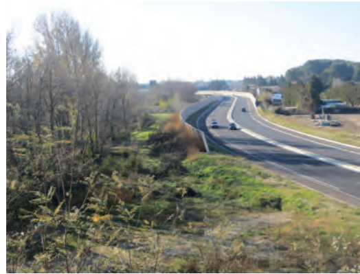
Berges contraintes (déviation)
