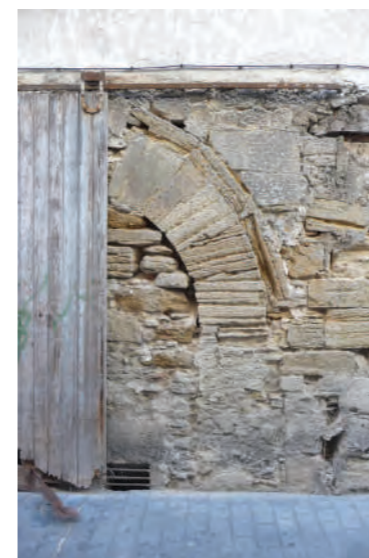
Vestiges d'un portail à archivolte du XIV e s., Rue des Frères Laurent
