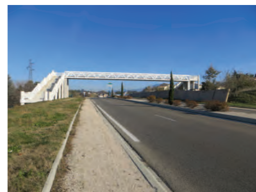
La liaison piétonne au dessus de la déviation. Une passerelle purement fonctionnelle.
