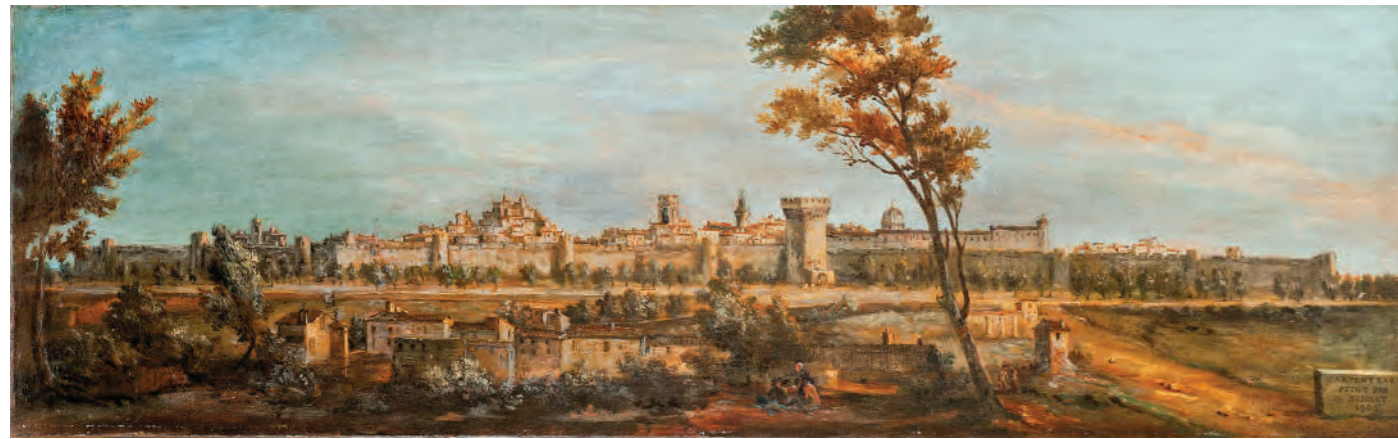
Reprographie de 1804. Vue du Nord depuis l'Auzon sur le rempart, les portes et les tours ceinturant la ville.
