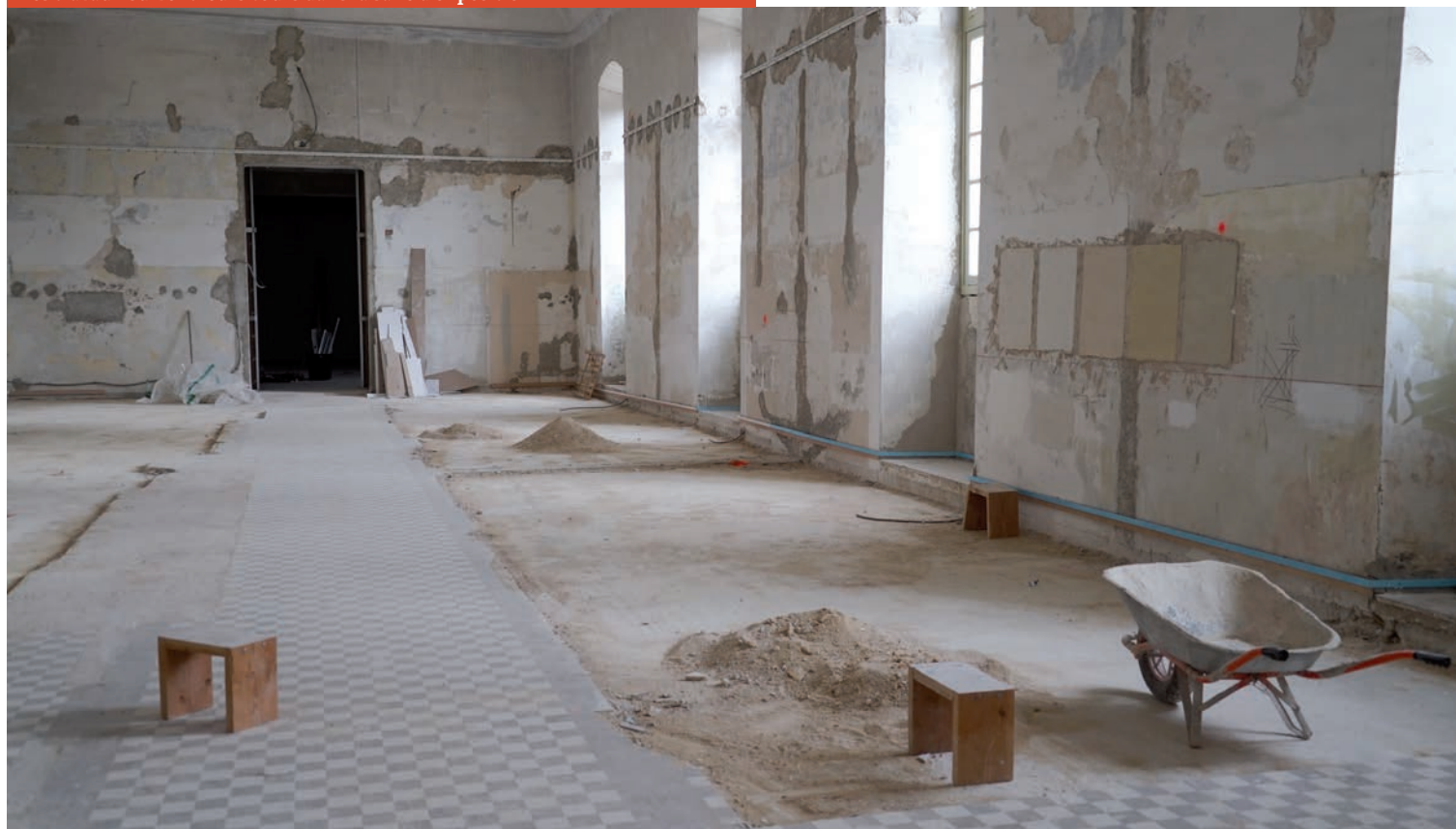
Les travaux suivent leurs cours dans la salle d'exposition
